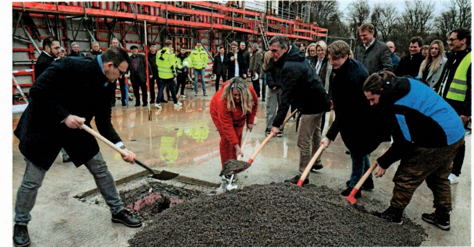
Bei der Grundsteinlegung für den Erweiterungsanbau der Städtischen Gesamtschule am Nußberg griffen unter anderem Bürgermeister Michael Joithe (li.), Schulleiterin Barbara Brühl (2. v. li.) und Ressortleiter Martin Stolte (3. v. li.) zur Schaufel.
